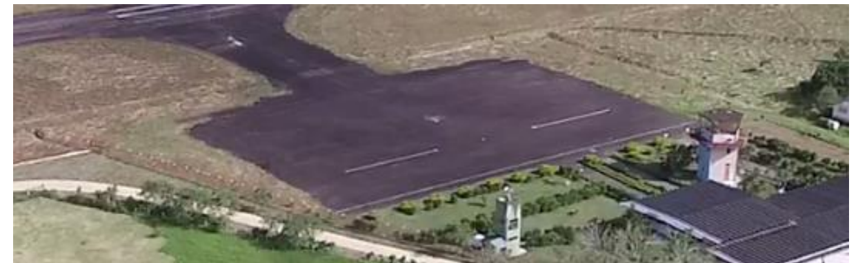
Figura 9. Plataforma de estacionamiento, señalamiento y estado
